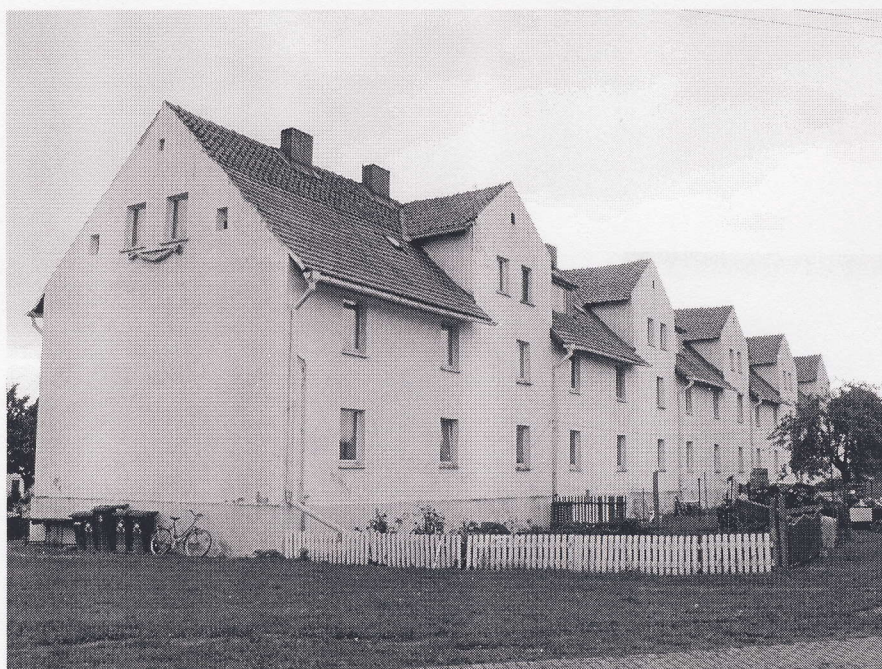
Baulich sanierte Schnitterkasernen in Klein Wanzleben
